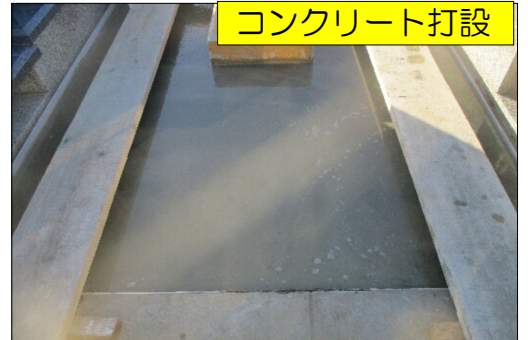
石籠浄土カロート 外柵 床下地一体化施工中
