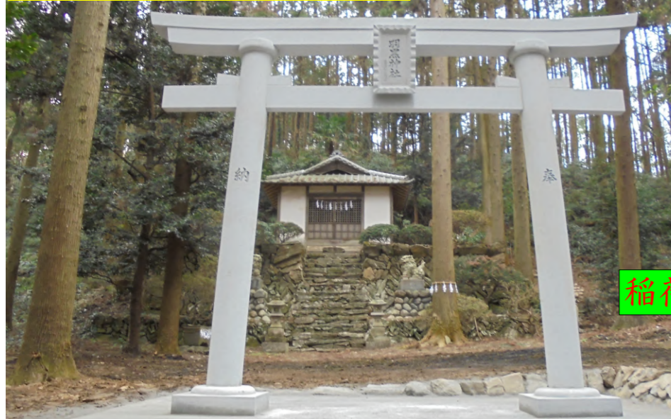
台輪付稲荷型鳥居 柱芯々9尺 柱直径9寸 柱半転び 笠 島木一体
