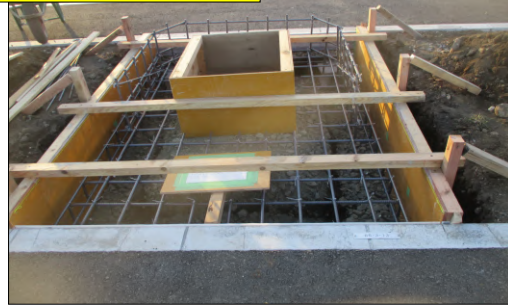
根伐 砕石敷込填圧 鉄筋配筋
