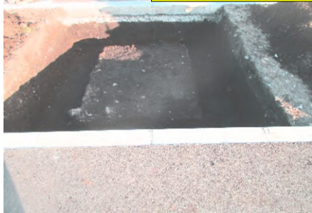
根伐 砕石敷込填圧 鉄筋配筋
