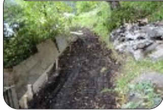
擁壁型枠完了時
