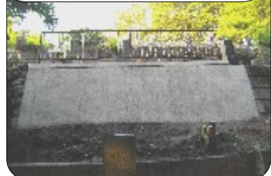
擁壁高さがある為フェンス設置
